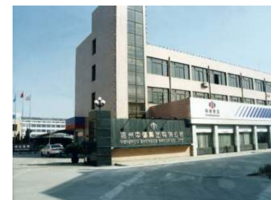
温州中德厂区
