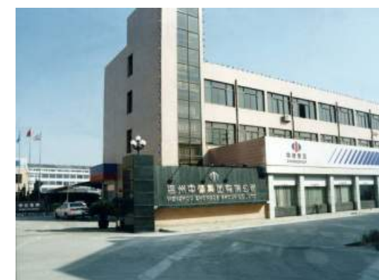
温州中德厂区
